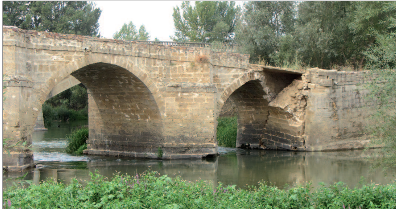
► Estado del puente, con parte del muro del estribo y una bóveda derruidos, en mayo de 2016. Debajo, socavón en la calzada superior de la estructura.
