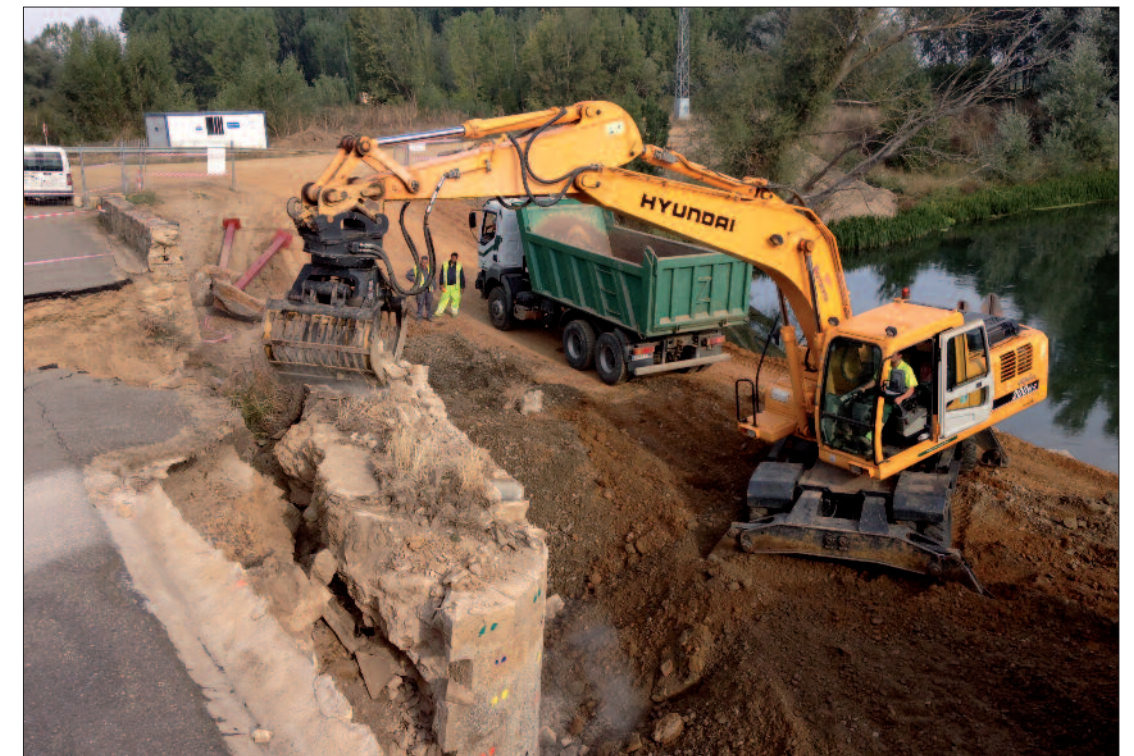
► Imágenes superiores, formación de la ataguía de tierra y apeo del muro dañado, con los sillares marcados en colores. Derecha, demolición selectiva del muro con medios mecánicos.
