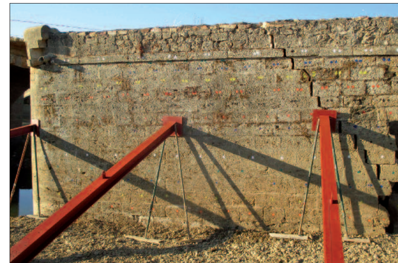
► Imágenes superiores, formación de la ataguía de tierra y apeo del muro dañado, con los sillares marcados en colores. Derecha, demolición selectiva del muro con medios mecánicos.
